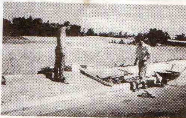
Budowa chodnika Postomino-Pieńkowo
