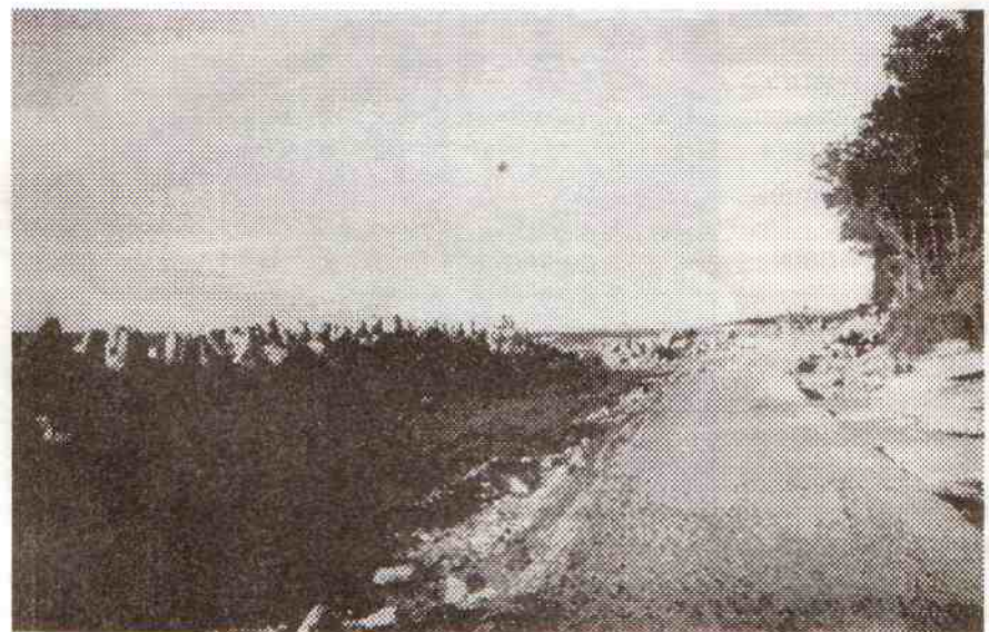
Umocnienia brzegu klifowego w Jarosławcu
