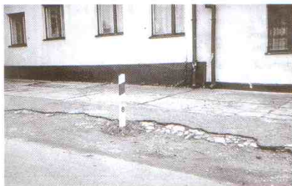
Słupek drogowy uniemożliwia swobodny dojazd do biura.
