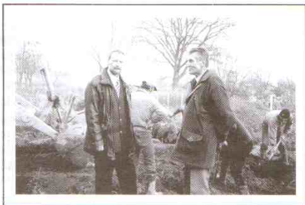
Wójtowie gminy Andrzej Kruczkowski i Henryk Koperkiewicz na placu budowy.
