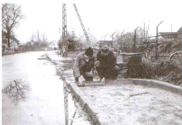
Mimo jesiennej szarugi prace przebiegają sprawnie.
