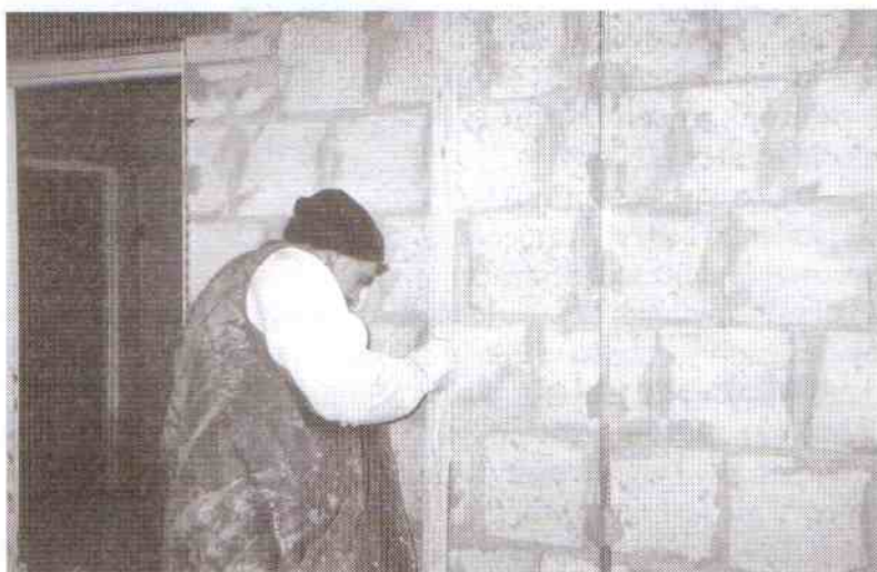
Monter - tynkarz Bogumił Świątek wykonuje prace przygotowawcze przed nałożeniem tynku.
