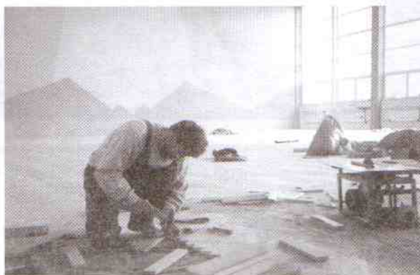
Podłoga w nowej sali gimnastycznej w Postominie prawie gotowa. Czy zdążą z otwarciem?
