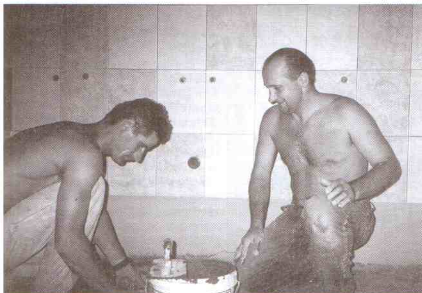
Andrzej Andrik i Waldemar Dybiec przy remoncie sanitariatów.
