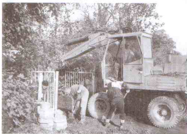
Kanalizację doprowadzono już do posesji p. Bendykowskich
