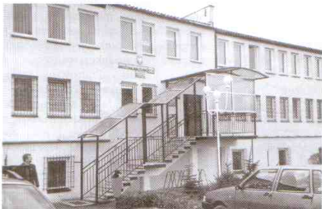
Nowa elewacja i nowe wejście do budynku Urzędu Gminy w Postominie.
