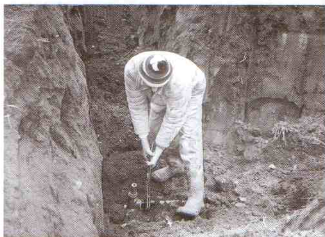
Ostatnie prace podłączeniowe do jednej z posesji w Roninie wykonuje Zbigniew Bartnik
