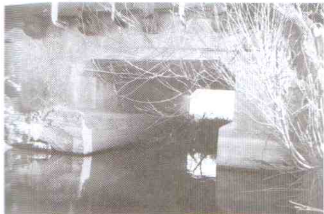
Tak w tym roku, w maju, wyglądała próba budowy tamy pod mostem na rzece Klasztornej
