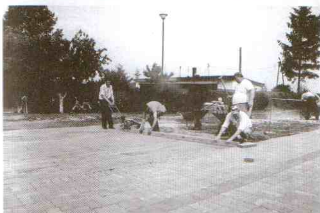
W szybkim tempie trwają prace przy układaniu kostki wokół Szkoły Podstawowej i Gimnazjum w Postominie
