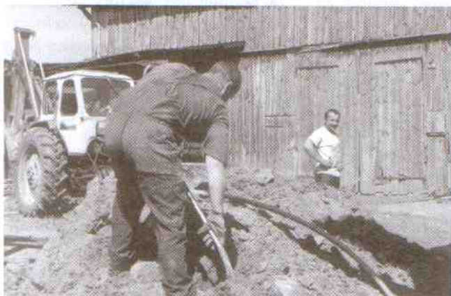
Bohdan Sadlowski i Tadeusz Pres kończą prace przyłączeniowe
