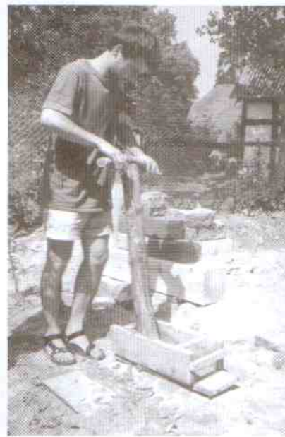
Juliusz Dudniczek demonstruje formowanie gliniano-słomianych cegieł. Za nim fragment narożnika powstającego domu szachulcowego
