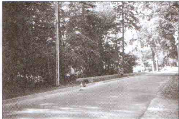
Budowa zatoki autobusowej w Roninie
