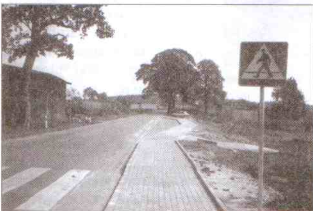
Budowa zatoki autobusowej w Masłowicach
