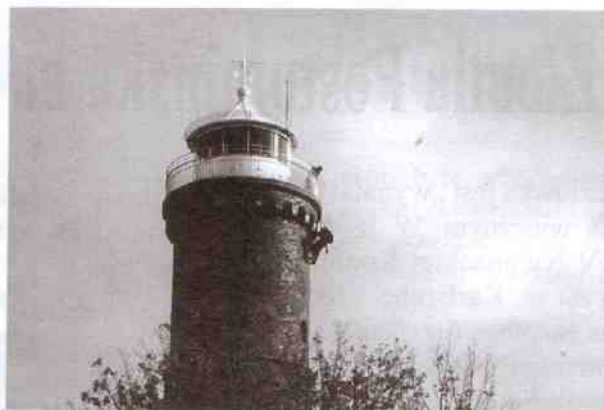
Niektóre prace konserwacyjne miejscowej latarni morskiej wymagają niezwyklej sprawności fizycznej
