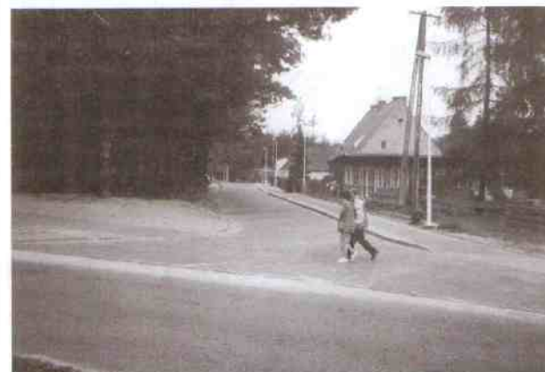
Nowa nawierzchnia ulicy Parkowej w Jarosławcu (w głębi parking).
