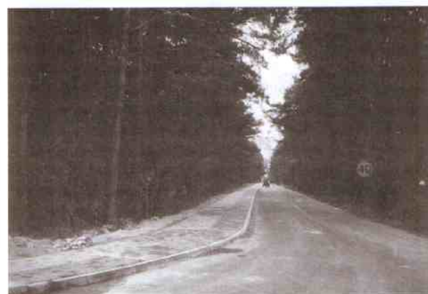
Trwają prace wykończeniowe modernizacji odcinka drogi z Rusinowa do Jarosławca (pas startowy).
