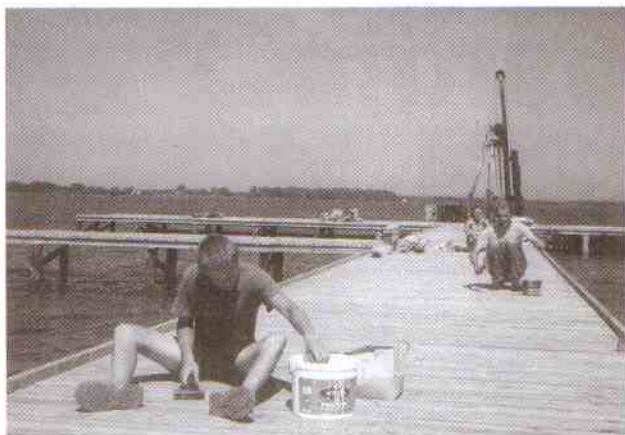
Na zdjęciu: końcowe prace przy pomoście w Łącku.
