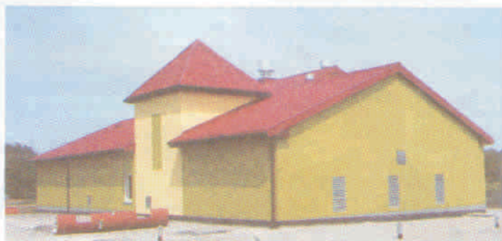
Oczyszczalnia ścieków w Jarosławcu
