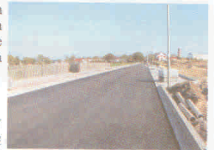
Asfalt na ul. Bałtyckiej w Jarosławcu
