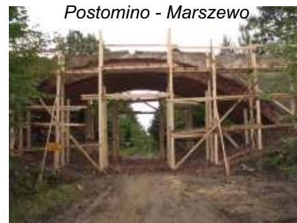
Remont mostu na drodze Postomino - Marszewo
