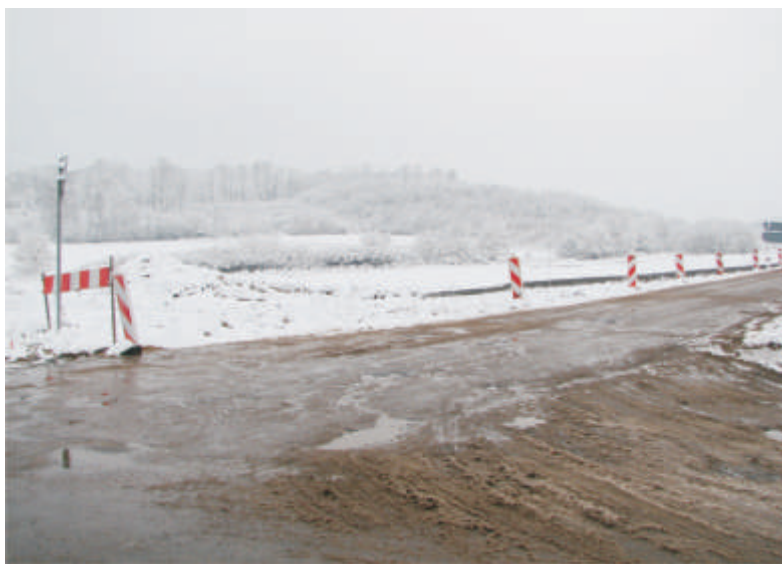
Budowa ronda w Kaninie
