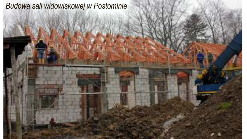
Budowa sali widowiskowej w Postominie
