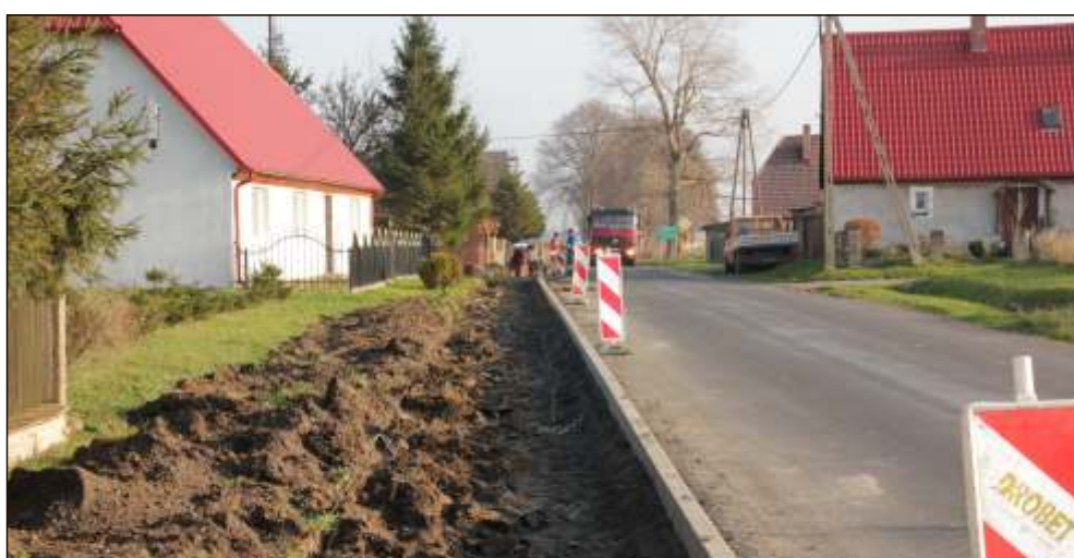
Budowa odcinka chodnika z przebudową zatoki autobusowej wzdłuż drogi powiatowej w m. Nacmierz
