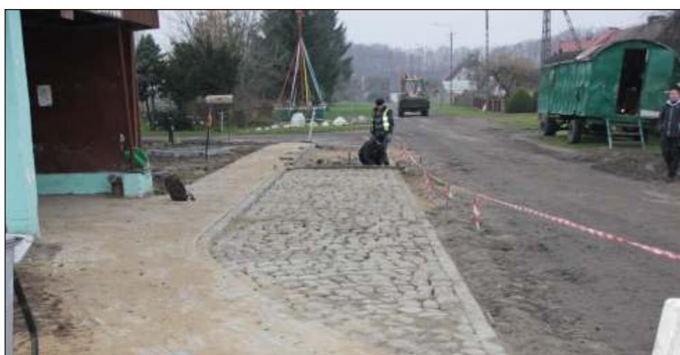
Przebudowa zatoki autobusowej z ciągiem pieszym w pasie drogi powiatowej w m. Wilkowie
