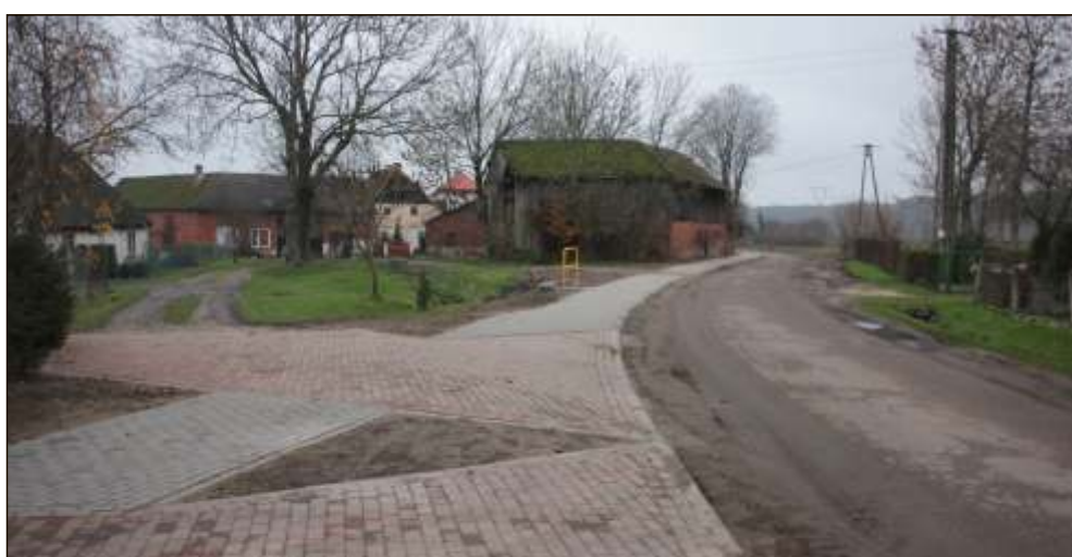
Budowa odcinka ciągu pieszego w pasie drogi powiatowej w m. Staniewice
