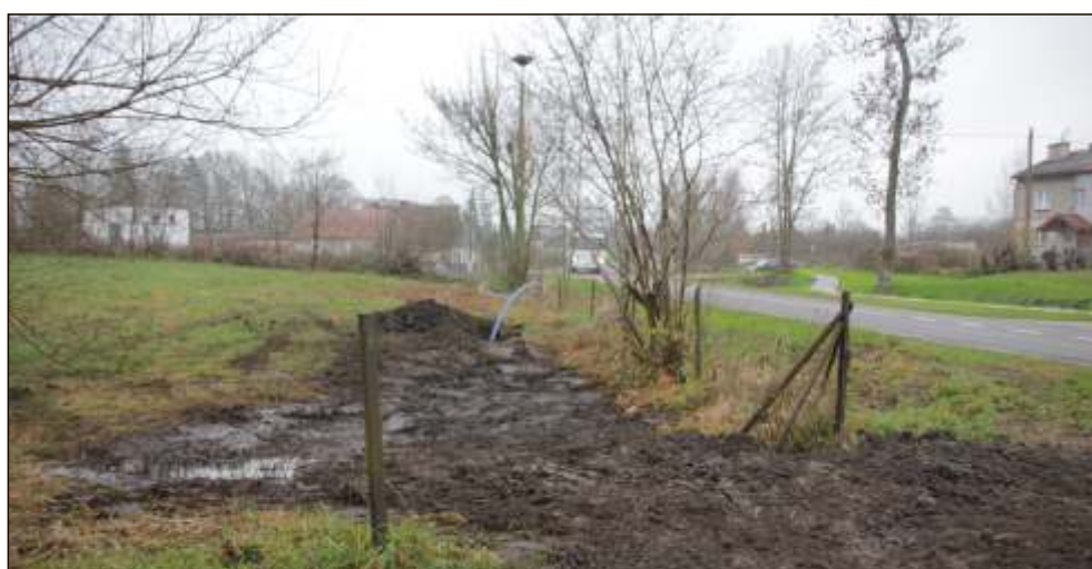
Budowa sieci wodociągowej wraz z przyłączami w m. Tyń
