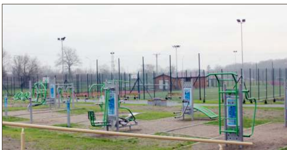
Budowa obiektów małej architektury w miejscowości Postomino
