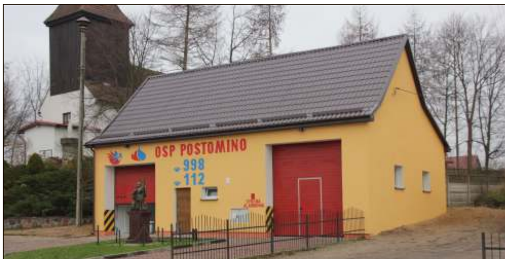
Remont remizy OSP Postomino
