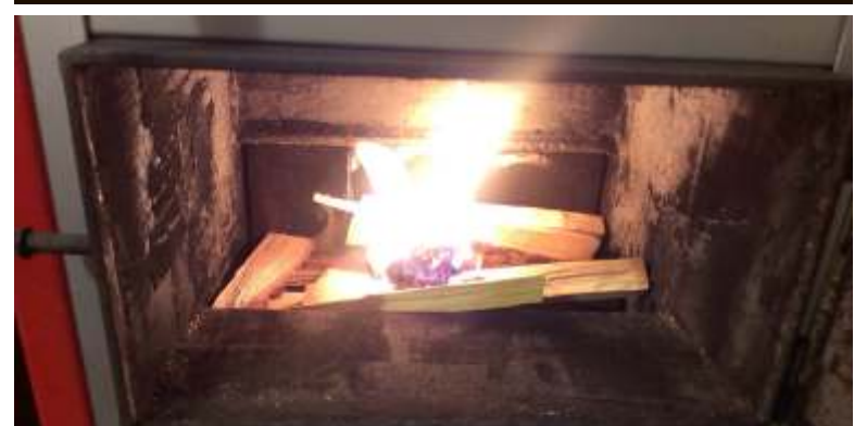
Palenie rozpoczyna się od góry, dzięki czemu rozpoczęty zostaje proces dokładnego i oszczędnego spalania
