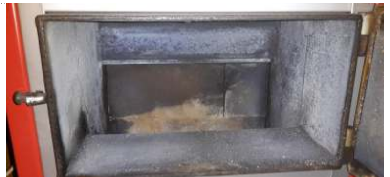
Kocioł po ostatnim paleniu - brak jakichkolwiek zanieczyszczeń, wszystko dokładnie się wypaliło
