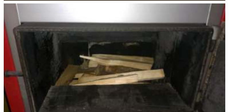
Kocioł zasypany węglem z warstwą drewna - drewno znajduje się na górze paleniska, a pod nim warstwa węgla
