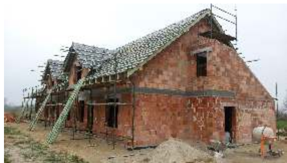
Trwają roboty przy budowie wielorodzinnego budynku socjalnego w Pieńkowie
